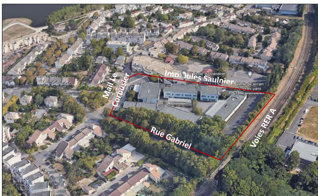
Figure 1 - Photo du site avec l'ancien lycée provisoire
